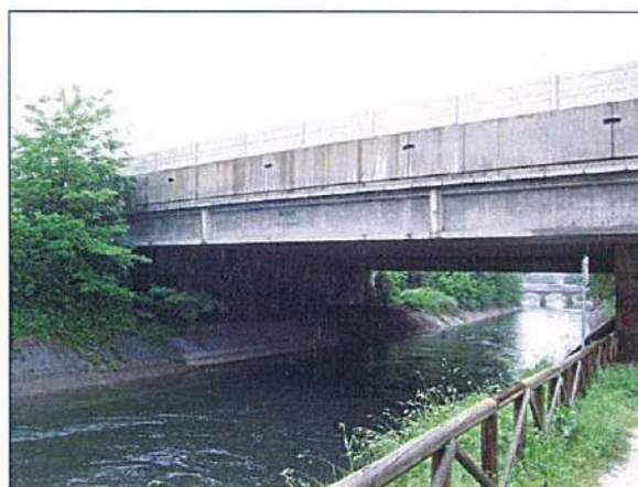
Figura 35. Ponte sul canale Villoresi Km 9+335.
