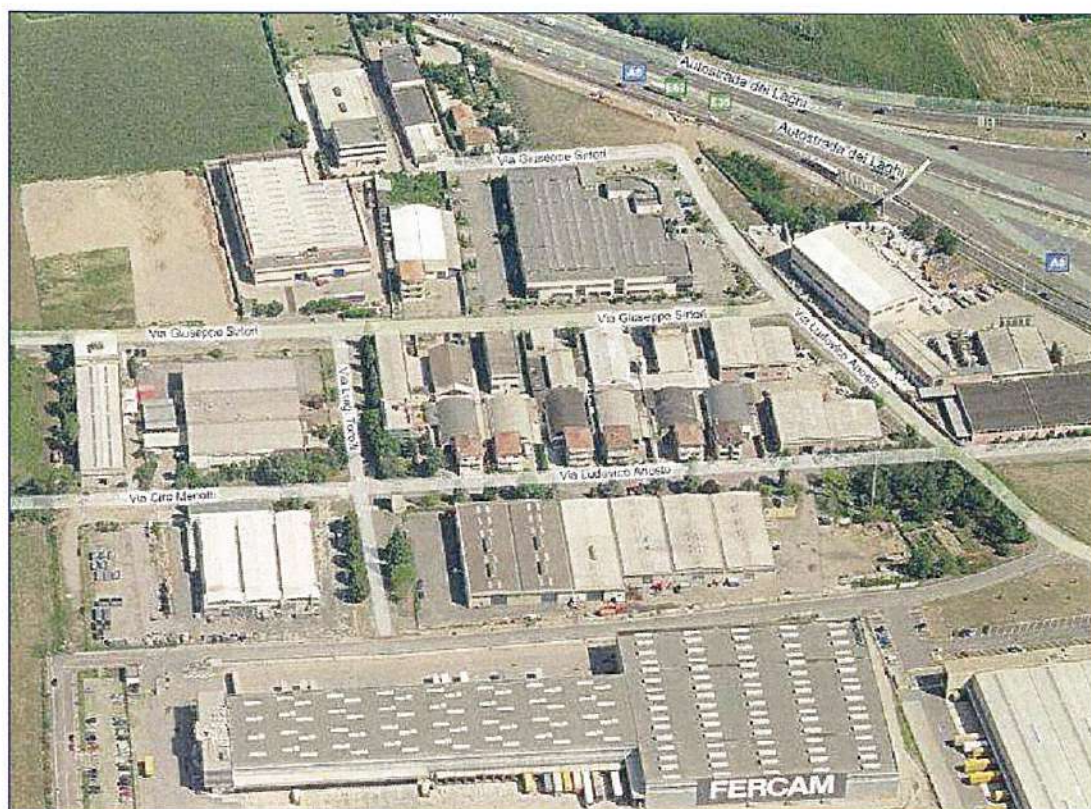
Figura 62. Area industriale adiacente alla diramazione tangenziale Ovest.
