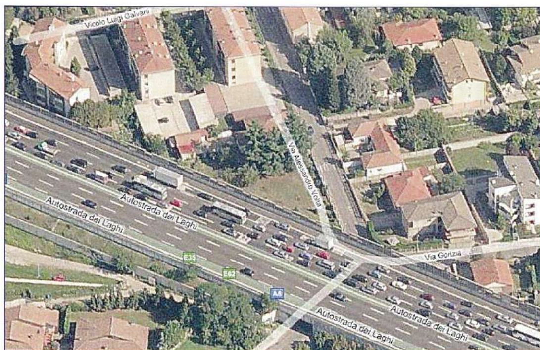
Figura 61. Edifici in linea in aderenza al sedime autostradale.
