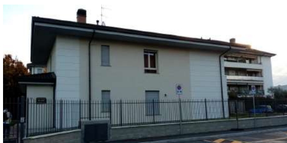
Casa Fa.Ro, inaugurata a fine 2021, due appartamenti per progetti di sperimentazione della vita autonoma e housing temporaneo. Nel seminterrato è prevista la realizzazione di un centro diurno per persone con disabilità lievi
