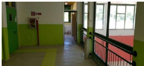
Scuola primaria Don Gnocchi: pavimentazione interna, completamento del piano seminterrato e nuova aula per la didattica all'aperto (1,8 mln €)
