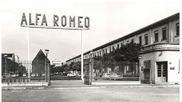
Foto: a sinistra veduta aerea di Alfa Romeo Arese; e qui sopra, sempre Alfa Romeo, ma “Portello” Milano.
